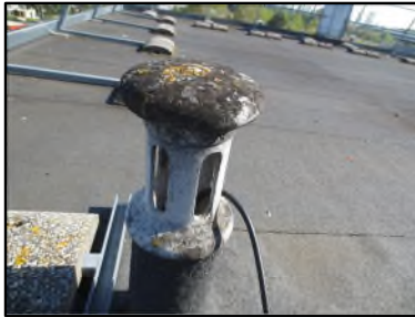
Photo N° 666 AMIANTE CIMENT -- Toiture terrasse Toiture Chapeau (Fibres-ciment)
